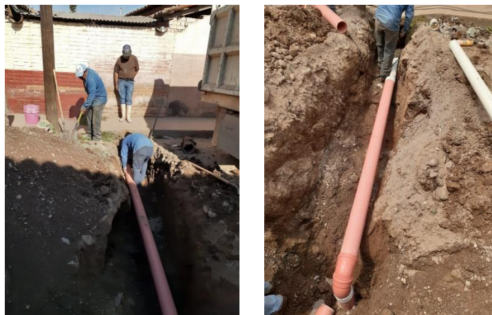
Imagen 2.3.1. Obra de renovación de tubo de atarjea 10" en calle Vallarta.
