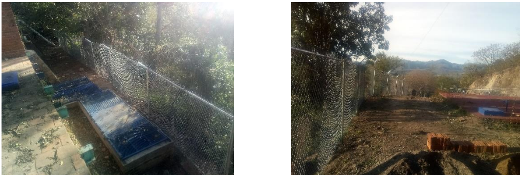
Imagen 2.2. Segunda etapa de colocación de malla ciclón en instalaciones del tanque de almacenamiento El Chivato.
