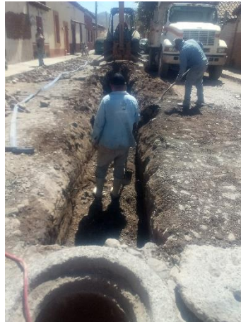
Imagen 2.3.2. Obra de renovación de tubo de atarjea 10" en calle Vallarta.
