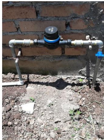
Imagen 2.4. Instalación de aparatos medidores de agua potable.
