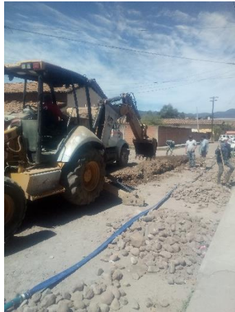
Imagen 2.3.2. Obra de renovación de tubo de atarjea 10" en calle Vallarta.
