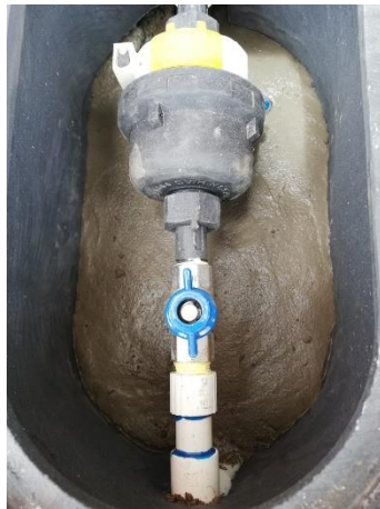
Imagen 2.4. Instalación de aparatos medidores de agua potable.
