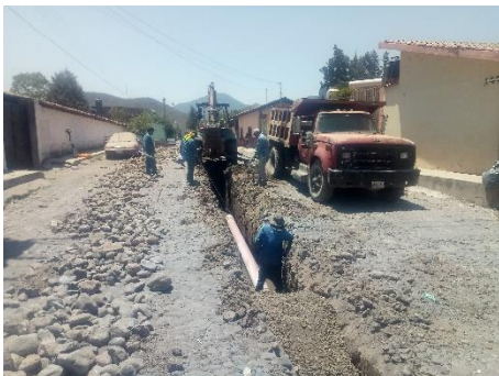
Construcción línea de atarjea red de drenaje en calle Insurgentes.
