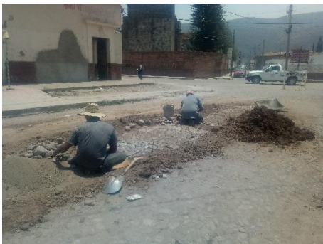
Construcción línea de atarjea red de drenaje en calle Venustiano Carranza.
