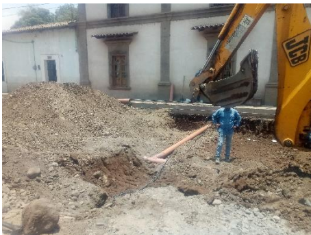
Construcción línea de atarjea red de drenaje en calle Justo Sierra.
