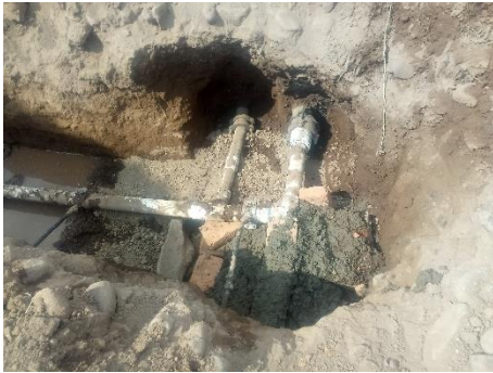
Construcción de crucero en red de agua potable sobre calle Juárez esquina Allende.
