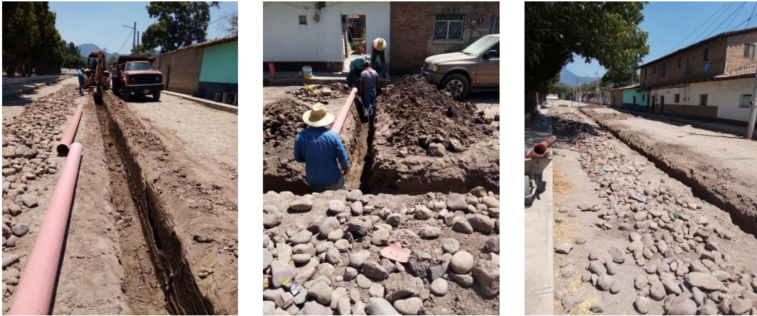
Imagen 2.3. Obra de renovación tubo de atarjea 8" en calle Núñez.
