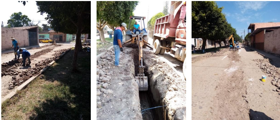
Imagen 2.2. Obra de extensión de tubo de atarjea 8" en calle Insurgentes.
