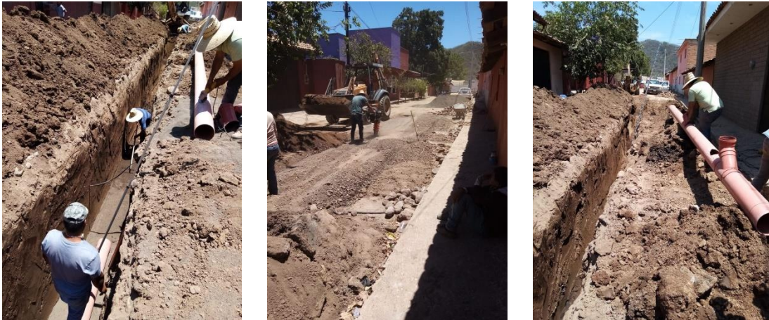
Imagen 2.1. Obra de renovación de tubo de atarjea 8" en calle Matamoros.
