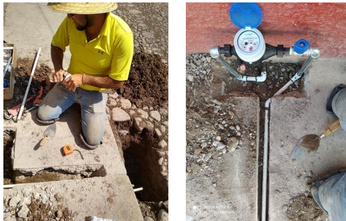
Imagen 2.4. Instalación de aparatos medidores de agua potable.
