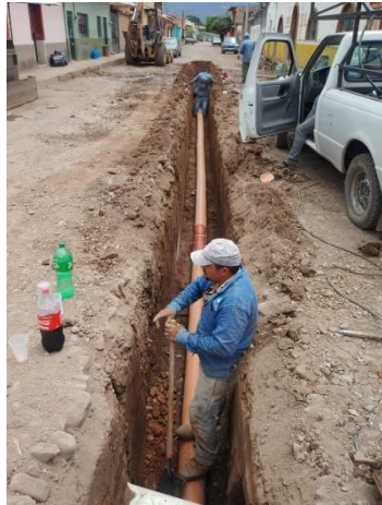
Renovación de línea de atarjea red de drenaje en calle Constitución.
