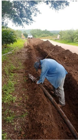
Renovación de la línea de conducción de las localidades Cruz Verde y El Refugio.
