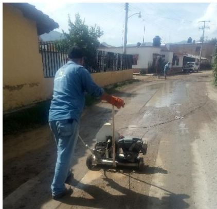
Trabajos de mantenimiento correctivo en línea de atarjea principal en localidad de Mirandillas.
