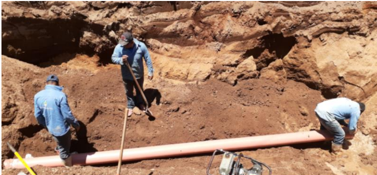
Imagen 2.3. Obra de renovación tubo de colector 16" y tubo de atarjea 8" en calle Libertad (continuación).
