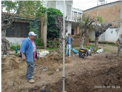
Imagen 2.2. Obra de renovación de tubo colector 16" en calle Libertad (continuación).
