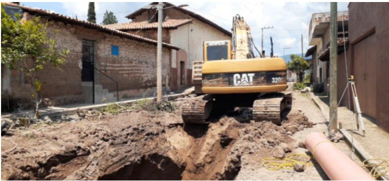
Imagen 2.3. Obra de renovación tubo de colector 16" y tubo de atarjea 8" en calle Libertad.
