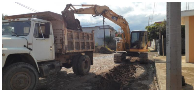
Imagen 2.4. Supervisión segunda etapa de la obra de renovación y sectorización de la red de agua potable.
