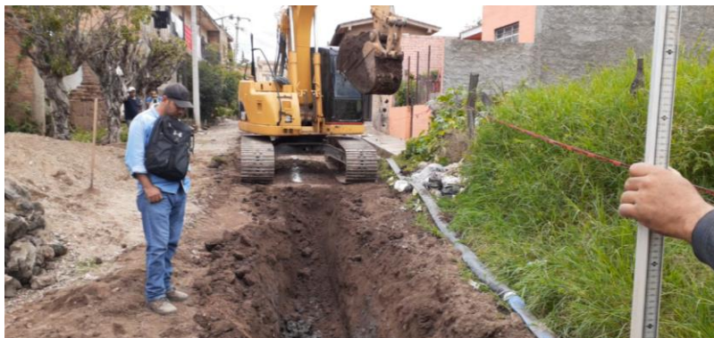
Imagen 2.4. Supervisión segunda etapa de la obra de renovación y sectorización de la red de agua potable (continuación).
