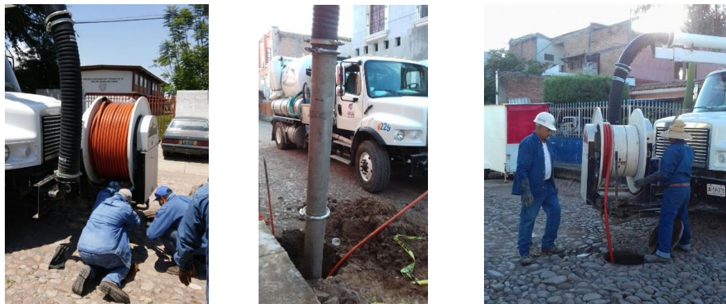
Imagen 2.1. Trabajos de mantenimiento en red de drenaje utilizando equipo hidroneumático.
