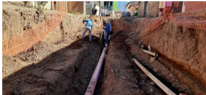
Imagen 2.1. Obra de renovación de tubo colector 16" en calle López Rayón (continuación).
