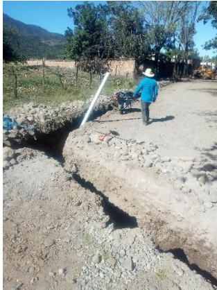
Imagen 2.3. Supervisión segunda etapa de la obra de renovación y sectorización de la red de agua potable.
