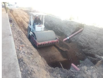
Imagen 2.2. Obra de renovación de tubo colector 16" en calle Libertad.
