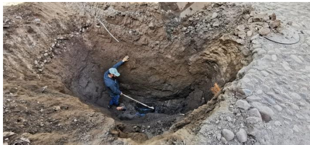
Imagen 2.6. Reparación de tubo colector de drenaje 12" en calle 5 de febrero.
