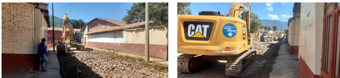
Imagen 2.1. Obra de renovación de tubo colector 16" en calle López Rayón.
