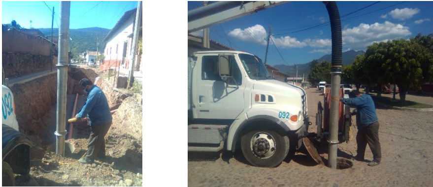
Imagen 2.5. Trabajos de mantenimiento en red de drenaje utilizando equipo hidroneumático.
