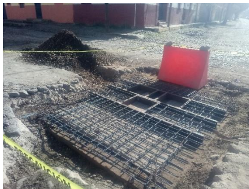
Imagen 2.4. Obra de extensión de tubería 8" circuito principal de agua potable en calle Hidalgo.
