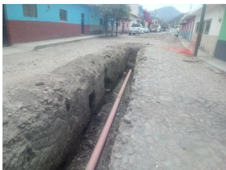
Imagen 2.1. Renovación red de drenaje en calle Insurgentes.
