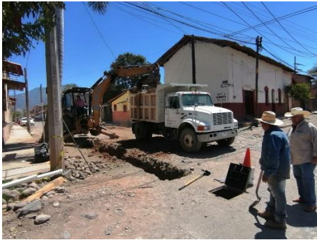
Imagen 2.2. Construcción de crucero red de agua potable en calle Emiliano Zapata.
