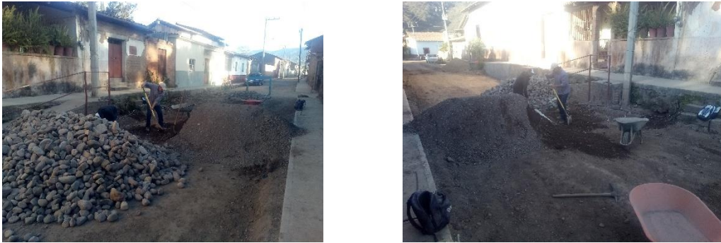
Imagen 2.2. Reposición de empedrado tradicional en calle Libertad.
