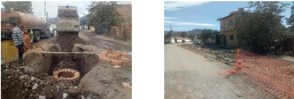
Imagen 2.2. Reposición de empedrado tradicional en calle Libertad.
