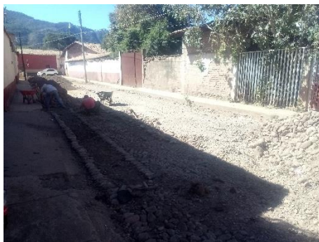
Imagen 2.1. Reposición de empedrado tradicional en calle López Rayón.
