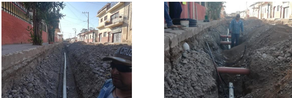
Imagen 2.4. Extensión de red de agua potable en calle Madero.
