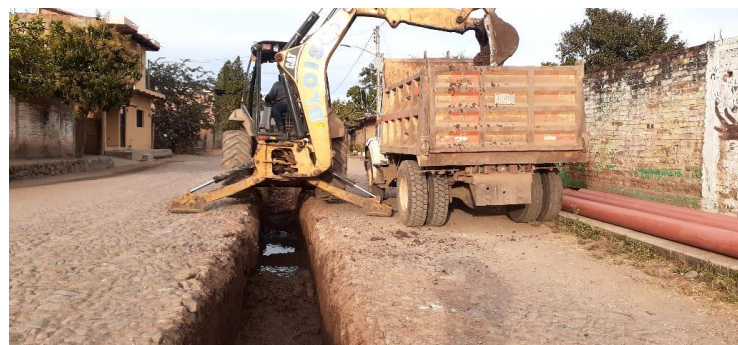
Imagen 2.3. Reparación de atarjea de drenaje en calle Leandro Valle.
