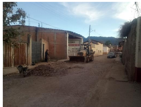
Imagen 2.1. Reposición de empedrado tradicional en calle López Rayón.
