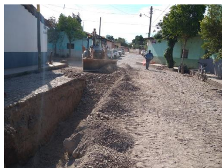
Imagen 2.1. Renovación red de drenaje en calle Insurgentes.
