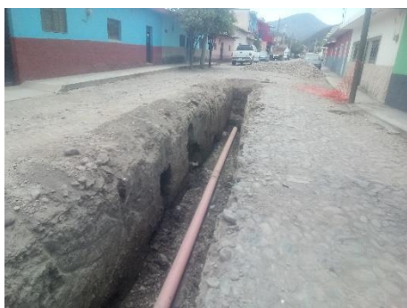
Imagen 2.1. Renovación red de drenaje en calle Insurgentes.
