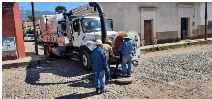
Imagen 2.1. Mantenimiento a la red de drenaje de la cabecera municipal.
