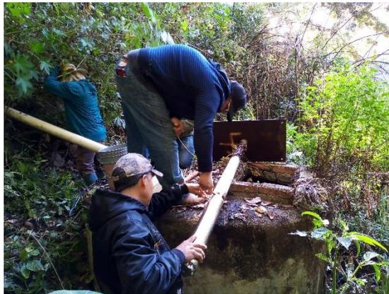
Imagen. Sustitución de bomba sumergible, localidad de Guayabitos, Mascota.
