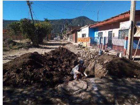
Imagen 2.3. Construcción red primaria agua potable 8" de diámetro en calle Emiliano Zapata (continuación).
