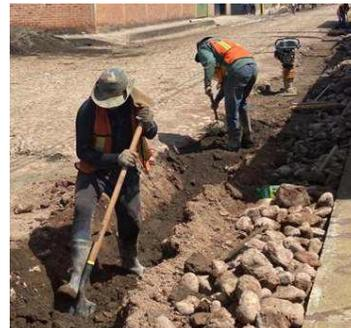
Imagen 2.3. Construcción red primaria agua potable 8" de diámetro en calle Emiliano Zapata.
