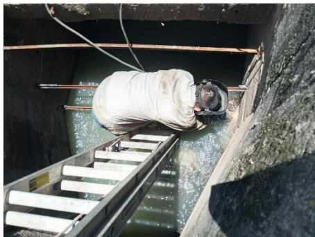
Imagen 2.3. Reparación de cribas en cárcamo de bombeo.
