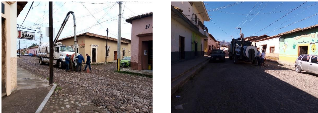
Imagen 2.1. Mantenimiento de red de alcantarillado sanitario.
