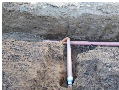
Imagen 2.1. Obra de renovación de red de alcantarillado sanitario.
