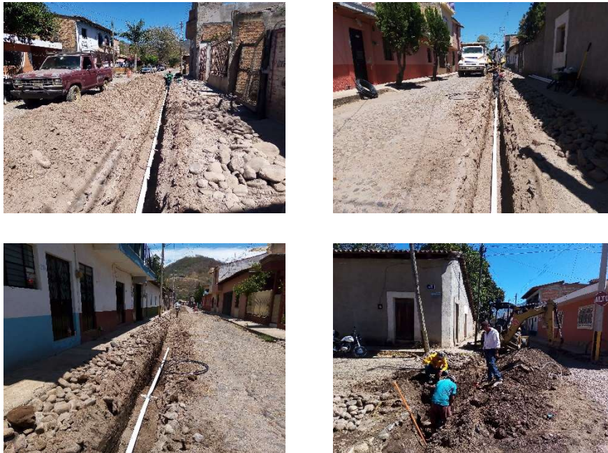
Imagen 2.2. Obra de renovación y sectorización red de agua potable.
