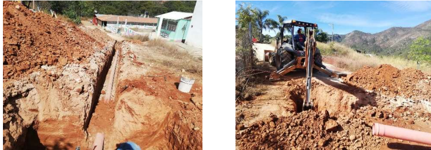
Imagen 2.1. Obra de extensión de drenaje en Las Cocinas.
