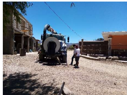
Imagen 2.2. Mantenimiento de la red general de drenaje con equipo hidroneumático.
