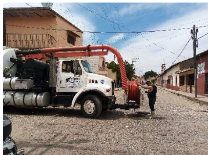
Imagen 2.2. Mantenimiento de la red general de drenaje con equipo hidroneumático.
