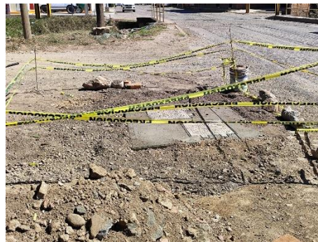
Imagen 2.3. Caja de válvulas tipo 4 – Maestras Valdéz.
