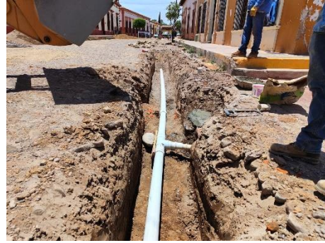
Imagen 2.1. Construcción de línea de agua potable en calle Hidalgo (continuación).
