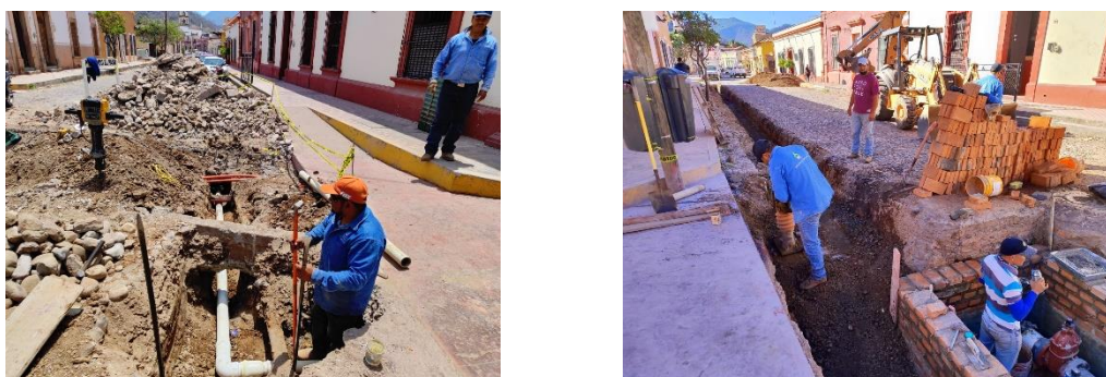
Imagen 2.1. Construcción de línea de agua potable en calle Hidalgo.
