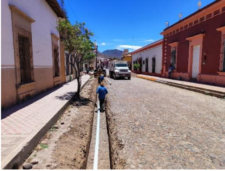
Imagen 2.1. Construcción de línea de agua potable en calle Hidalgo (continuación).
