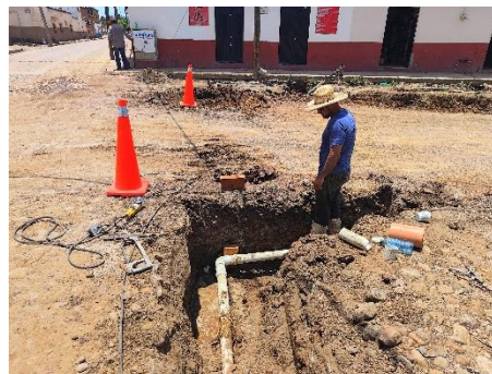
Imagen 2.4. Construcción de línea de agua potable en calle Venustiano Carranza (continuación).
