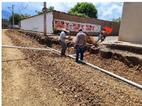
Imagen 2.4. Construcción de línea de agua potable en calle Venustiano Carranza (continuación).
