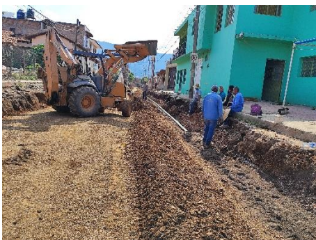
Imagen 2.4. Construcción de línea de agua potable en calle Venustiano Carranza.
