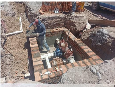
Imagen 2.2. Caja de válvulas tipo 13 – Hidalgo esq. Nicolás Bravo.
