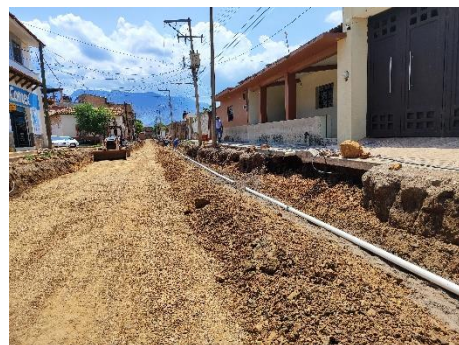
Imagen 2.4. Construcción de línea de agua potable en calle Venustiano Carranza.
