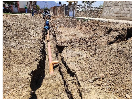
Imagen 2.3. Construcción de colector, línea de atarjea y descargas en calle Venustiano Carranza.
