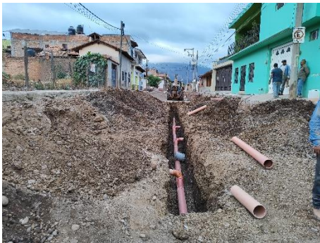
Imagen 2.3. Construcción de colector, línea de atarjea y descargas en calle Venustiano Carranza.
