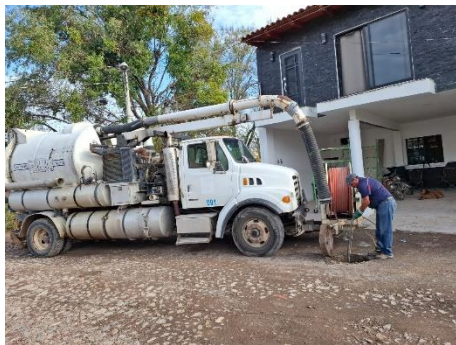
Imagen 2.2. Mantenimiento de la red de alcantarillado con equipo hidroneumático.
