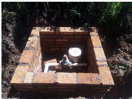
Imagen 2.3. Caja de válvulas en obra de extensión de red de agua potable calle Prolongación Juan Álvarez.
