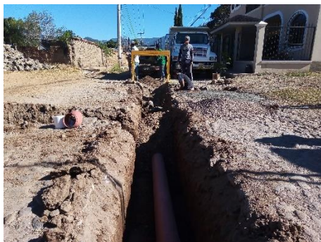
Imagen 2.3. Obra de extensión de red de alcantarillado sanitario calle Leona Vicario.
