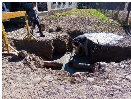
Imagen 2.3. Obra de extensión de red de alcantarillado sanitario calle Leona Vicario.
