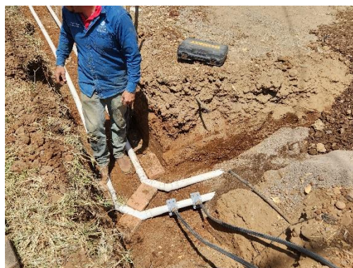
Imagen 1.1. Obra de extensión de red de agua potable en localidad de El Refugio.
