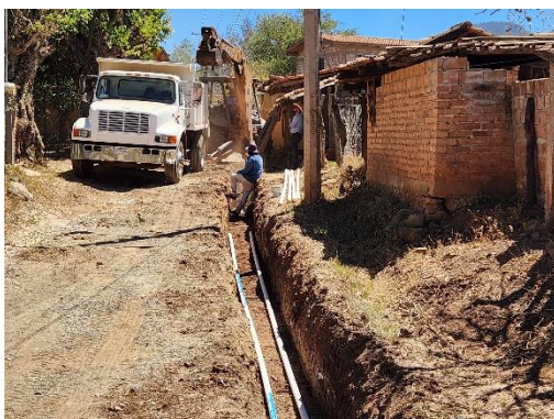
Imagen 1.1. Obra de extensión de red de agua potable en localidad de El Refugio.
