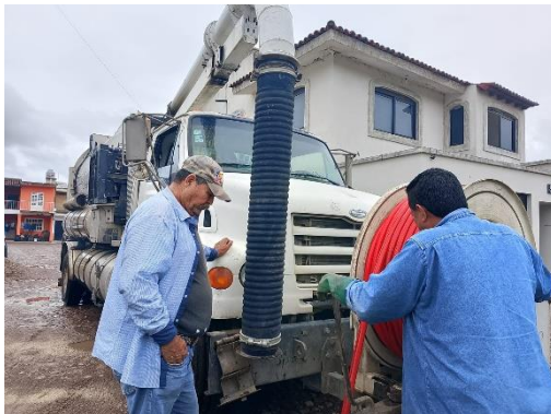
Imagen 1.3. Mantenimiento general de la red de alcantarillado sanitario.
