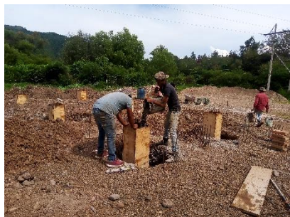
Imagen 1.1. Obra de cimentación para paneles solares (continuación).
