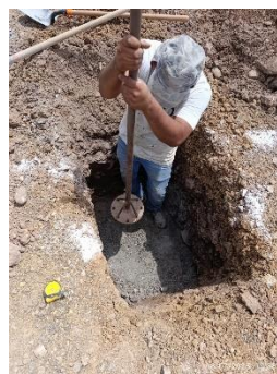
Imagen 1.1. Obra de cimentación para paneles solares.
