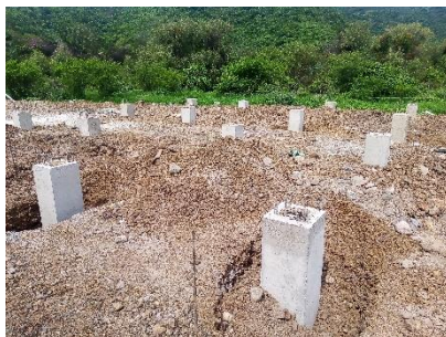
Imagen 1.1. Obra de cimentación para paneles solares (continuación).
